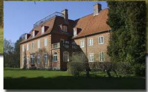
Magleås Kursuscenter oprindeligt opført i 1910 som privatbolig for Familien Westenholz.
