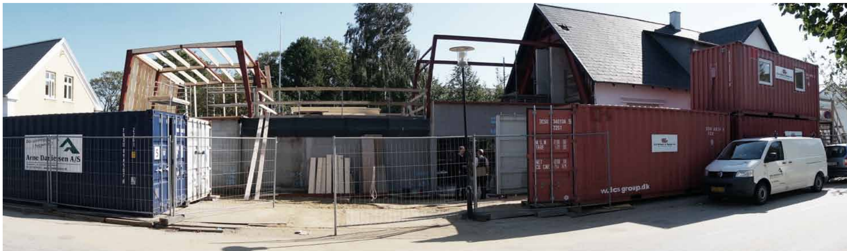
byggeplads set fra gaden
