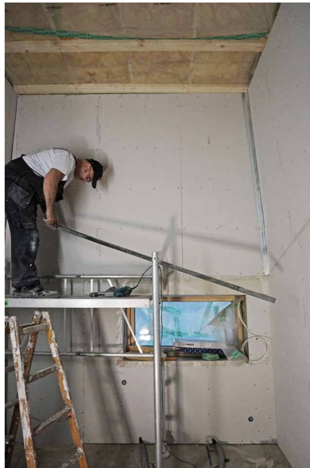
Ny tagkonstruktion til kontorknast
