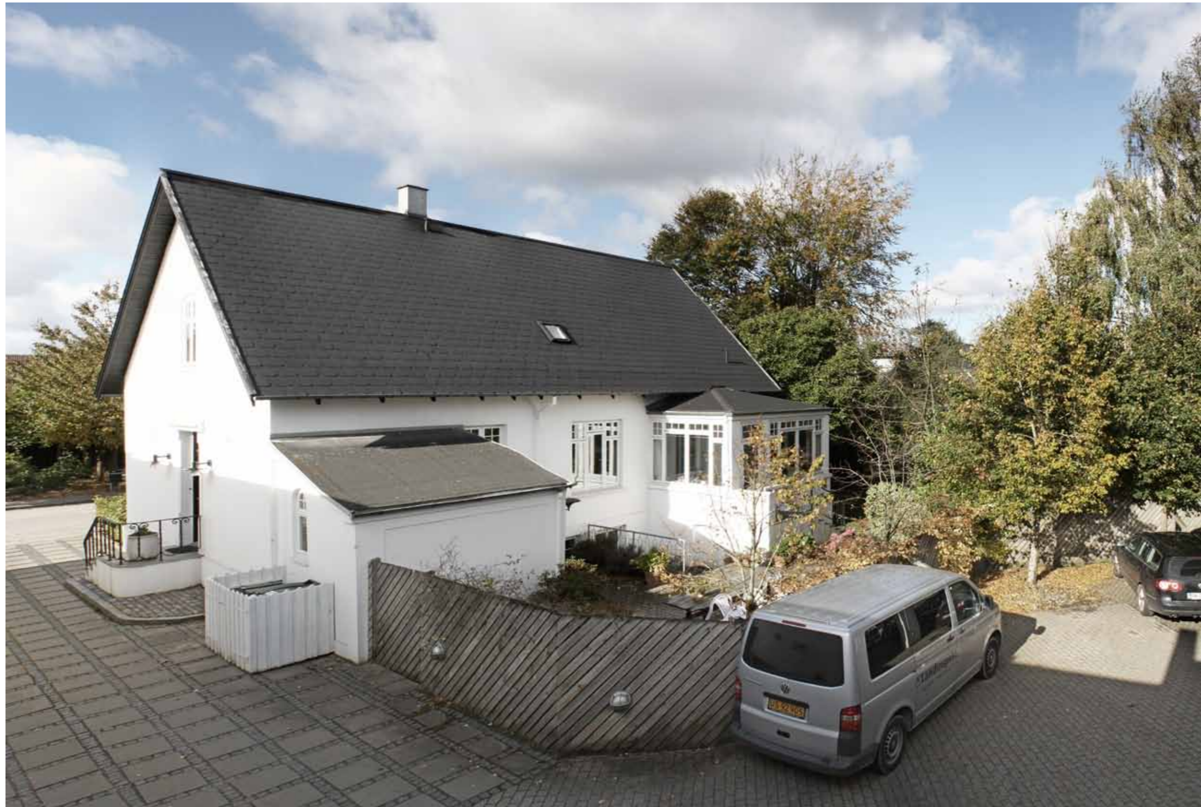
Eksisterende Villa, set fra havesiden
