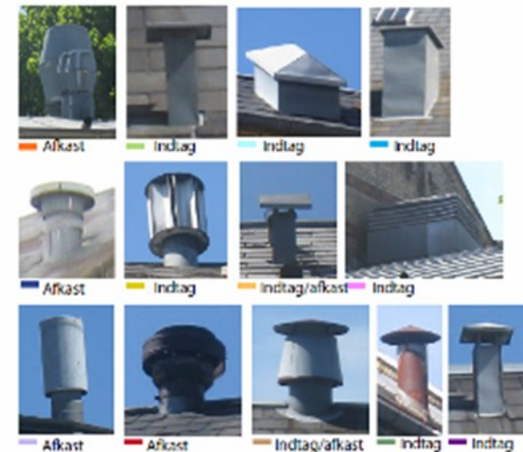
Existerende taghætter og ventilationskorstene - funktionsoverdigt
