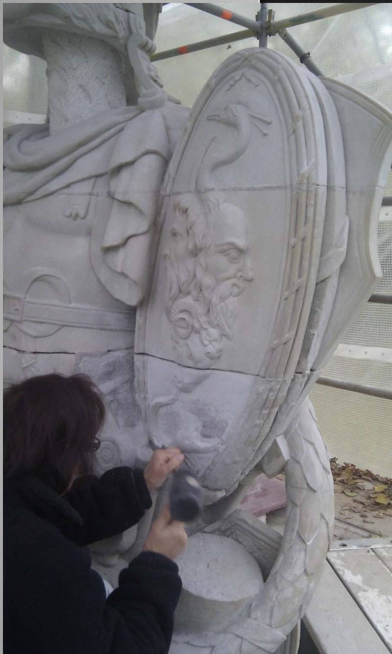
Tilbagehugning i eksisterende sandsten
