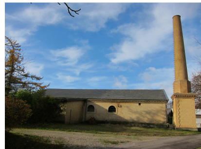
På østsiden anes tilbygningen fra 1901, som dog er delvist skjult af buskadset,
