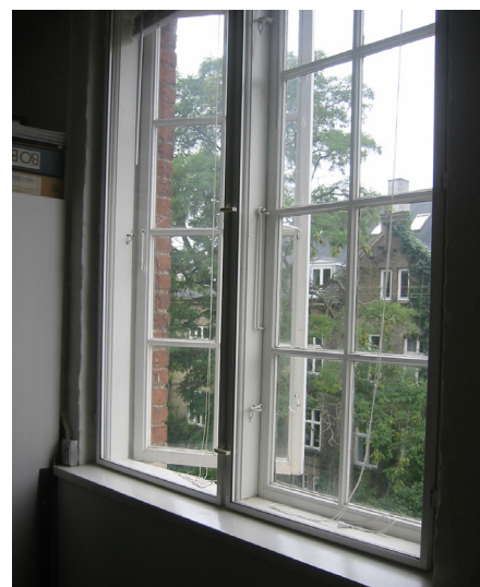
Udvendigt kitfalsvindue med et indvendigt forsatsvindue med energilas, den såkaldte Forsats 1+1-løsning. Denne har rimeligt gode energiegenskaber, et energital på \div 58 \text{ kWh/m}^2 \text{ år} og en U-værdi på 1,65 \text{ W/m}^2 \text{ K} for hele vinduet. Så denne løsning opfylder det skærpede Bygningsreglement for 2010 (BR10)
