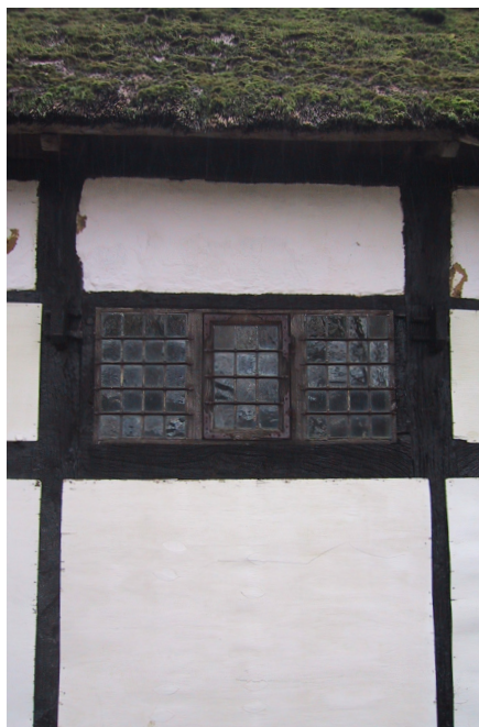
Blyopsprosset vindue fra slutningen af 1600-årene.
