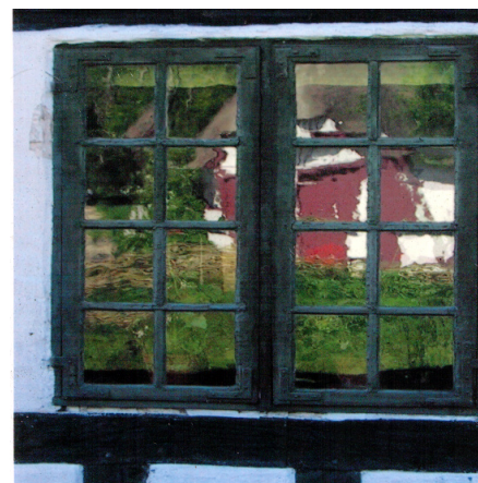
Vindue med ruder af cylinderglas.
