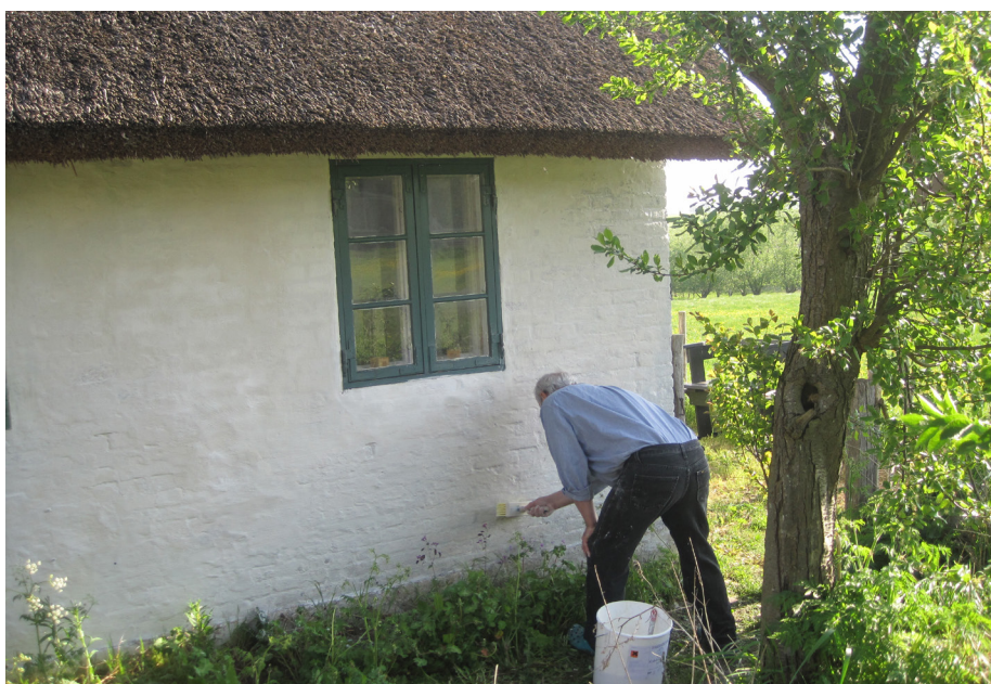
Vedligeholdelse er nødvendigt, men det kan også være en tilfredsstillende at få sit hus sat i god stand med jævne mellemrum. Ud over at huset får et pænt og velholdt udseende, opnår man også at komme på nært hold af bygningen, hvorved småskader bliver opdaget, inden de udvikler sig til store og dyre problemer.
