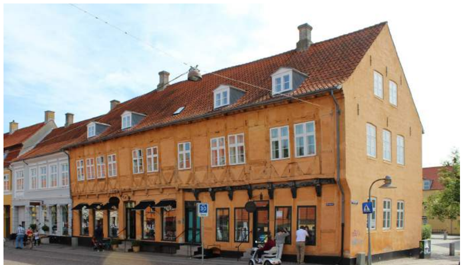
Senmiddelalderligt bindingsværkshus i Køge, opført ca. 1500. Stort stokværksfremspring støttet af lange, krumtvoksende skråstivere. Foto: Anne Lindegaard.
