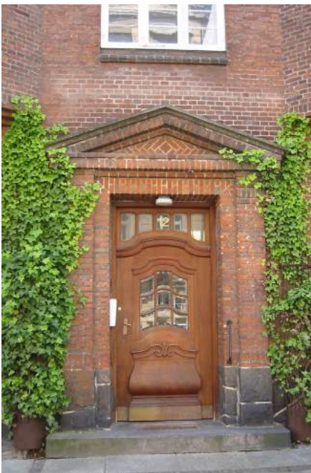
Nationalromantisk etagehus på Østerbro i København. Præget af de røde 'nationale' mursten og hvide sprossevinduer, hvor de små rudeformater vender tilbage, til trods for at glasteknologien sagtens kunne fremstille større ruder. I den 'barokke' hoveddør ses de meget moderne spejlglasruder af støbt og maskinslebet glas.
