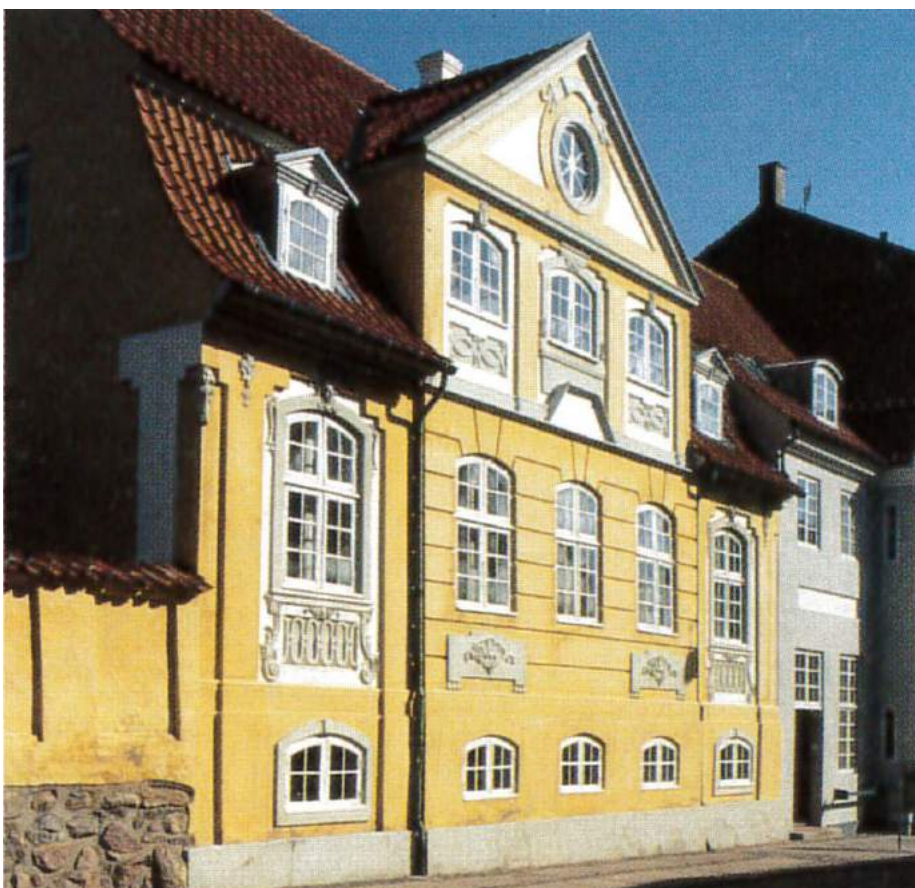
Rigt udsmykket rokokohus fra 1763, Lindegade 4 i Kalundborg, med øreliséner, vinduesindfatninger og refendfugning.
