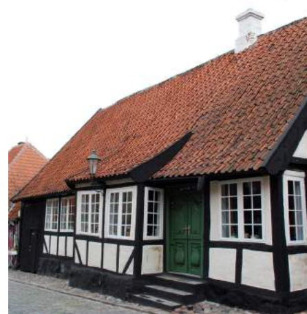
Velbevaret, fredet, barokt bindingsværkshus i Årskøbing. Barokken var meget glad for kraftige farver, så huset har formentlig oprindeligt haft en mørk rød eller en dyb gul farve. Foto: Bente Lindegaard.
