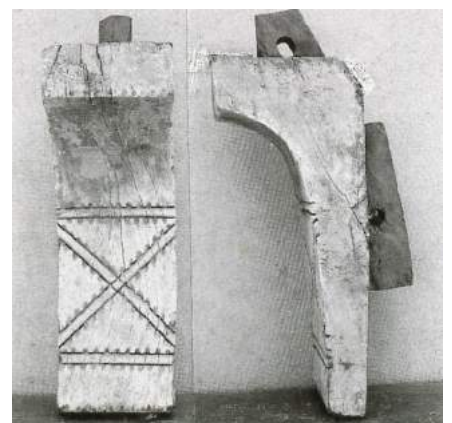
Gotisk svejftet knægt med udstukket andreas kors fra omkring 1550. Typisk for den sene del af middelalderen. Foto: HHE.
