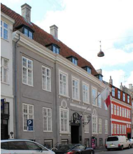
Lille Strandstræde 14 i København. Barokkens store gavlkvist går af mode ligesom de kraftige facadefarver. I stedet får huset et let fremhævet midterparti, lyse pastelfarver, kold grå og hvide gesimser, bånd og indfatninger. Facaden er strengt symmetrisk, dog er vinduernes tværpøst rykker op, så den vandrette symmetri i disse forrykkes.
