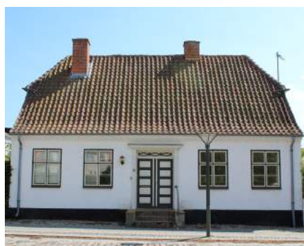
Bedre Byggeskik-hus med nyklassicistiske træk: Pudset facade, den tofløjede, symmetriske indgangsdør med en klassicistisk fordakning båret af indfatninger samt de klassicistiske vinduer i to farver. Foto: Anne Lindegaard.
