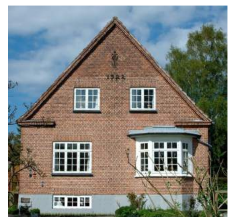
Bedre Byggeskikkens hus i Fredensborg. Røde mursten, opskalket tegltag, hvide småsprossede vinduer, klassiske danske gesimsformer – og den lysgivende halve, sekskantede 'Tønder-karnap'.
