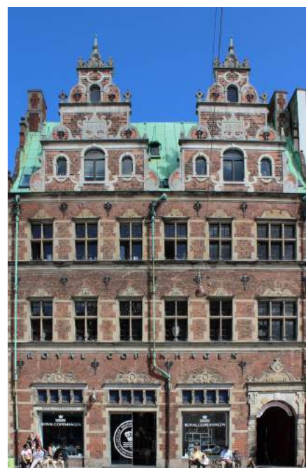
Amagertorv 6 i København. Opført i 1616 af borgmester Mathias Hansen i nederlandsk renæssance. Typisk for denne er det blanke murværk af mørkerøde hollandske teglstensmopper kombineret med rige sandstensdekorationer omkring porten, vinduer, døre og gavle. Typiske er også de svungne hollandske gavle og det stejle tag, der her er beklædt med kobberplader. De kraftige spygatter / vandudspyer er fornemt udformet som dragehoveder. Huset blev restaureret i 1898 af arkitekten, professor H.J.Holm, som en af de første deciderede restaureringer i Danmark.
