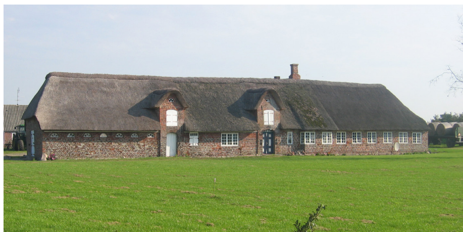
Tidligt i 1800 årene blev det almindeligt at opføre grundmurede huse i Sønderjylland, og fra midten af 1800-tallet bliver bindingsværket over det meste af landet udkonkurreret af muret byggeri. Foto: Anne Lindegaard
