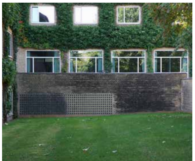
Støttemur mod sletten
