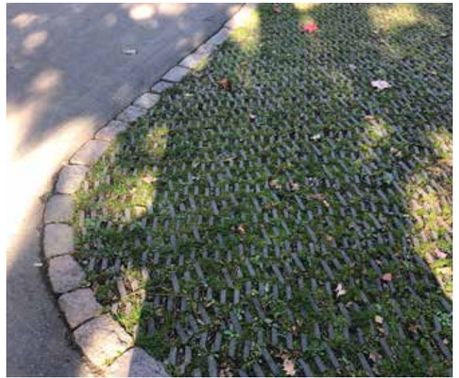
Græsarmering af beton ved sletten
