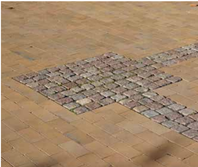
Belægning ved Nørrebrogade
