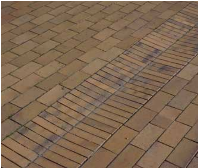
Regnvandsrender i gården ved universitetets første bygning
