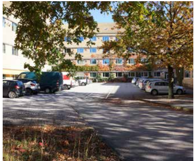
Bygningsnær parkering ved Ny Munkegade
