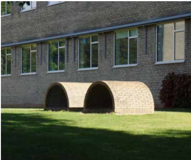
Udluftningsanlæg ved sletten
