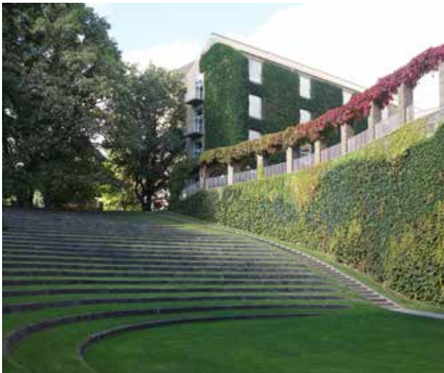
Vedbend og rådhusrvin ved Aulabygningen
