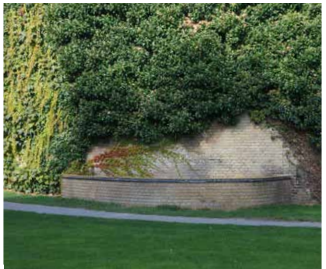
Halvmur skærmer kildens udspring nedenfor Aulabygningen
