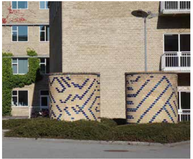
Udluftninger med blåglaseret mønstermurværk ved 'atomkælderen'
