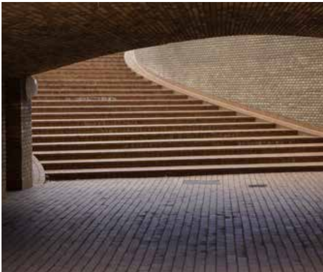
Gangtunnel i tegl fra Nordre Ringgade til Universitetsparken
