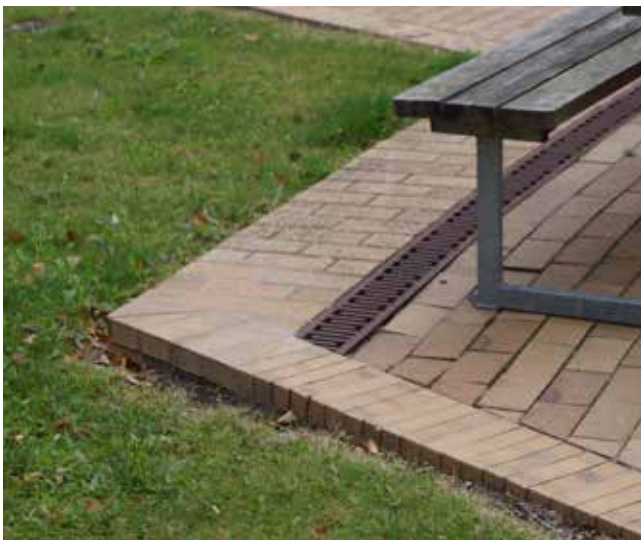
Kantet, nyere belægning med flere slags tegl
