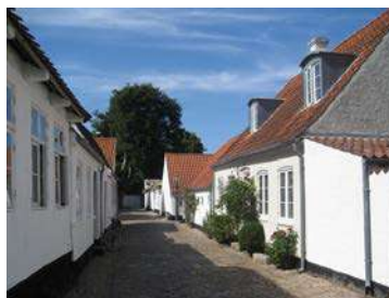
Bygninger vender med både langsiden og gavl til gaden. Tage med rødt tegl. En mindre del af tagene har kviste. Forskellige vinduer. Trappetrin i granit.
