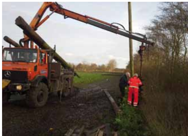
Opsætningen af de svære stolper til udkigstårnet er ingen sag, når man får god og kompetent hjælp. Foto: Olav Martinsen.
