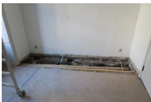
Foto 3, bundremmen i skillevæggen som er undersøgt.
