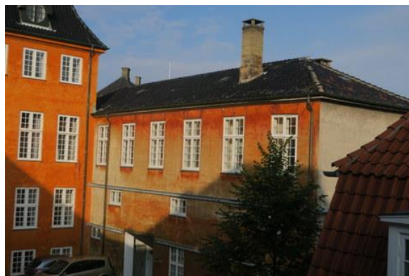
Foto bygningens tagflade set fra gården.
