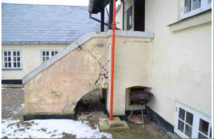
Foto nr. 10. Trappe mod nord
