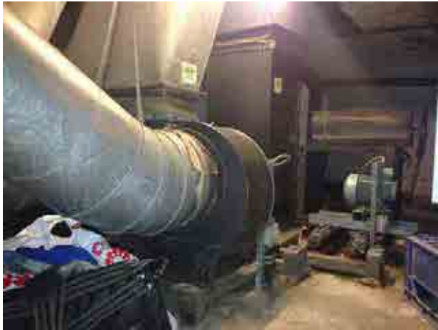
I ventilationsrummet på loftet i bygning B ses de oprindelige rørføringer fra sugekamrene til de fire oprindelige mekaniske anlæg.
