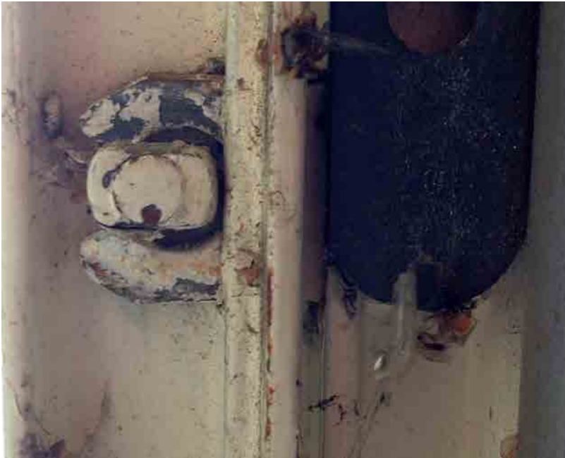
Vinduerne består af to rammer, låst sammen med det lille lukkebeslag. Beslaget drejes og rammerne kan åbnes og pudses. Hvis beslaget ikke drejes tilbage i lodret position holdes rammerne ikke samene og vinduet kan ikke lukkes tæt.
