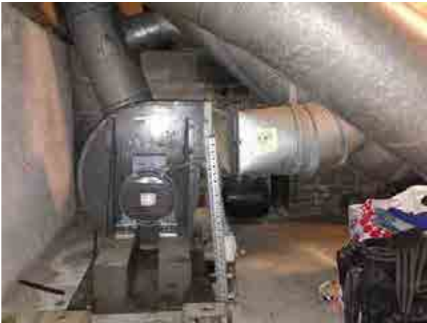
I ventilationsrummet på loftet i bygning B ses de oprindelige rørføringer fra sugekamrene til de fire oprindelige mekaniske anlæg.
