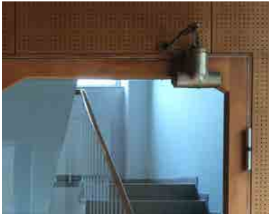
Ældre dørpumpe på glasdør.
