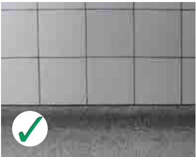
Terrazzo og hulkehl skal bevares.
