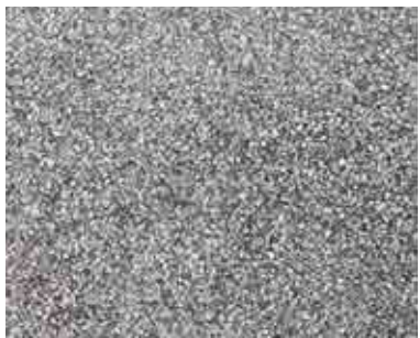
Oprindelig hvid terrazzo i toiletrum.
