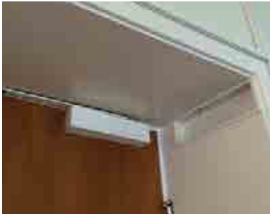
Udskæring i lysningspanel for pumpe.
