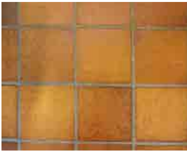
Nyere rødbrune klinker i toiletrum.
