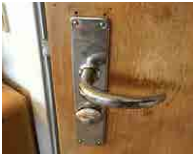
Spor efter ældre retkantet langskilt.
