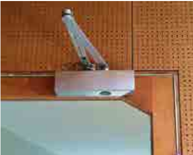
Nyere dørpumpe på glasdør.
