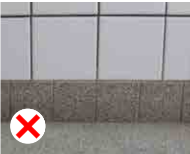
Sokkelfiser skal fjernes.
