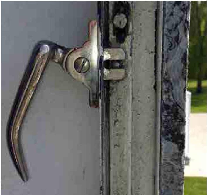
Vinduerne åbnebeslag i siderne og drejeleddet i top og bund midt for vinduet kan være vanskelige at betjene. Når beslagene smøres går de lettere og vinduet kan åbnes uden brug af kræfter.
