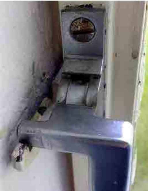
Vinduerne åbnebeslag i siderne og drejeleddet i top og bund midt for vinduet kan være vanskelige at betjene. Når beslagene smøres går de lettere og vinduet kan åbnes uden brug af kræfter.
