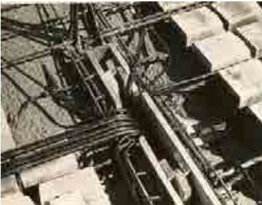
Indbyggede føringsveje for el.
