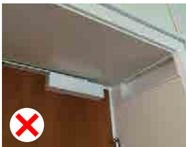
Udskæring for pumpe i lysningspanel.
