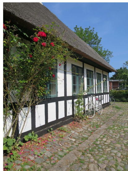
Stuehusets bindingsværk og ældre vinduer.
