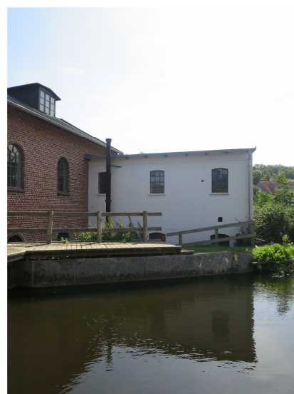
Møllesøen og møllebygningen ses fra nordvest med det hvidmalede maskinhus midt i billedet.
