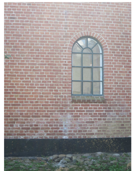
Støbejernsvindue i vandmøllen.
