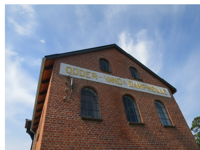
Den østvendte gavl med skilt og støbejernsvinduer.
