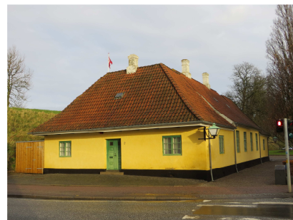
Hovedvagten med den sydvestre sidefløjs facade mod Danmarksgade.
