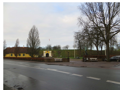
Hovedvagten er placeret ved Prinsens Port. På pladsen foran porten er det fredede mindesmærke Landsoldaten.
