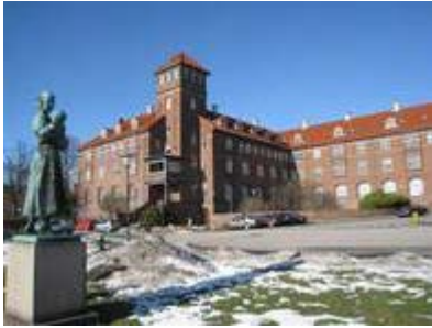
Bispebjerg Hospital, tegnet af arkitekt Martin Nyrop og opført 1908-13
