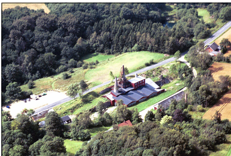
Mønsted Kalkværker blev restaureret i 2004. Foto fra Institutionen Mønsted Kalkgrubers hjemmeside.
