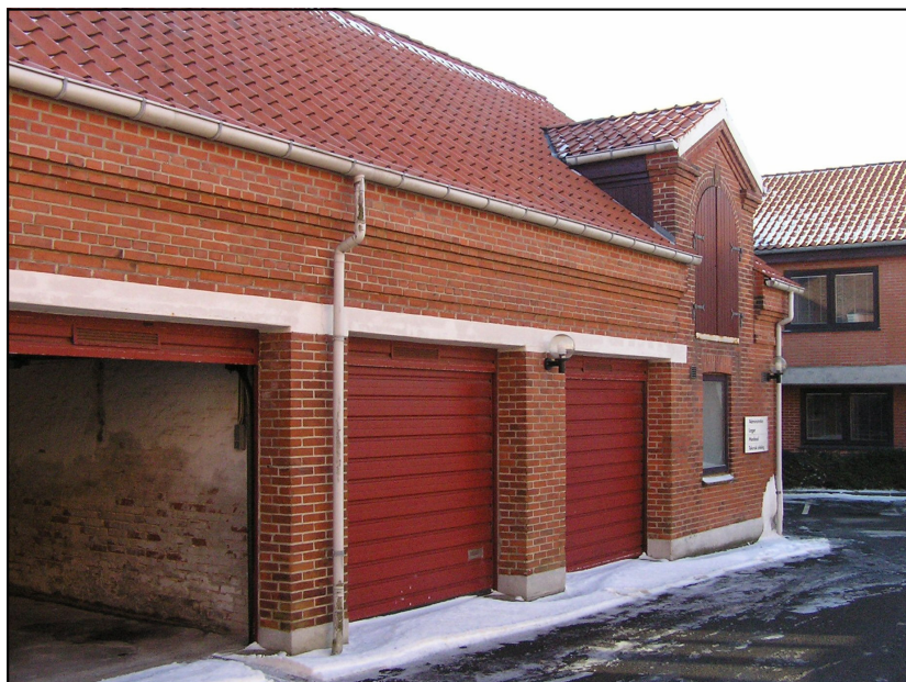
Bygningerne til Thy Højspændingsværk er i god stand. Foto: Thisted Museum.
