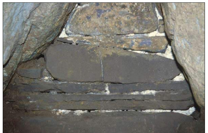
Fig. 10. Tørmur med kridtmasse. Den nederste sten på billedet er sålstenen. Foto: Torben Dehn
