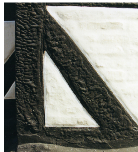
Til venstre: Sort trætjærefarve på bindingsværk. De små 'noprer' i overfladen bliver ikke bløde eller smitter af. Til højre: Sort stenkulstjære på bindingsværk. Denne er grovere i strukturen og bliver blød, smitter af og løber i stærk varme, f.eks. om sommeren. Foto: Anne Lindegaard.
