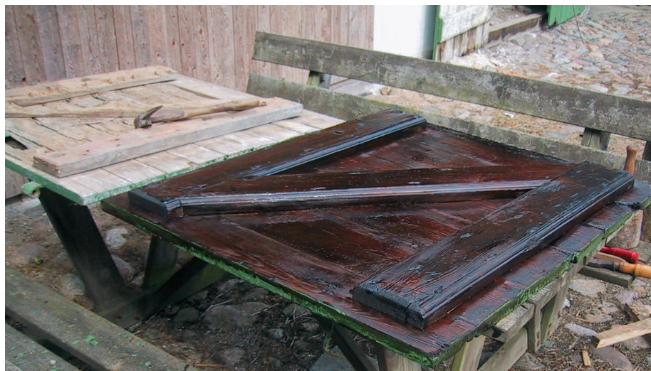
Regenerering af blødt træ med trætjære. Når trætjæren er hærde, bliver træet hårdt og vandafvisende igen.
