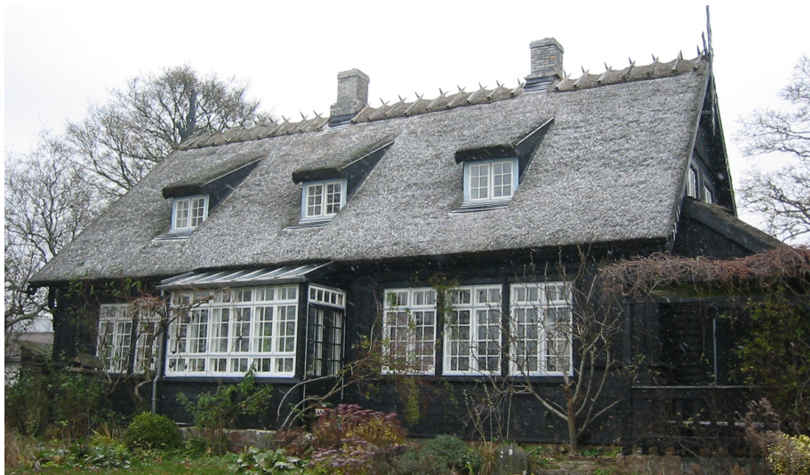
'Hytten' på Vallekilde Højskole tegnet af Martin Nystrup i 1898 er et træhus, der er overfladebehandlet med sort trætjærefarve.
