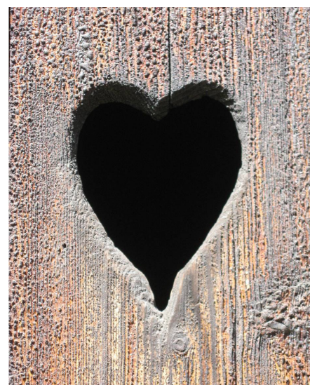
Ældre farvet træbjære har en overflade som krokodilleskind. Foto: Arne Høi
