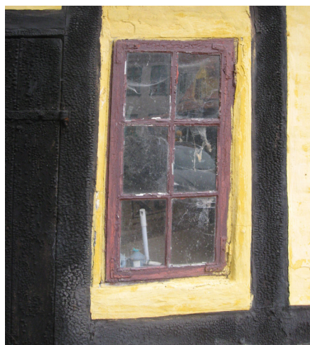
Til venstre: Sort trætjærefarve på bindingsværk. De små 'noprer' i overfladen bliver ikke bløde eller smitter af. Til højre: Sort stenkulstjære på bindingsværk. Denne er grovere i strukturen og bliver blød, smitter af og løber i stærk varme, f.eks. om sommeren. Foto: Anne Lindegaard.
