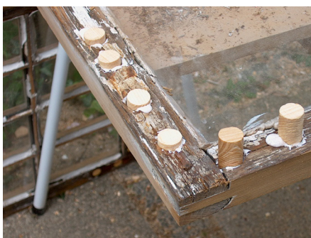
Udpropping af ødelagte skruehuller til beslagene. Propperne skal være skåret af sidetræ – ikke endetræ, og må ikke være af bøg. Bøg rådner meget hurtigt udendørs.
