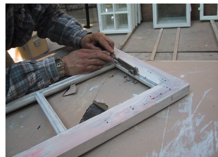
Udtagning af gamle glas skal ske meget nøjsomt, så disse kan sættes tilbage i vinduet igen. Her er vist et specialfremstillet, skarpt stemmejern, påmonteret et lille hjul eller styr, der gør at man kan skære den gamle kit løs, uden at glasset revner. Efter at kittet er fjernet skal man meget forsigtigt og omhyggeligt trække alle glasstifterne ud, hvorefter ruden er fri og kan lirkes ud.
