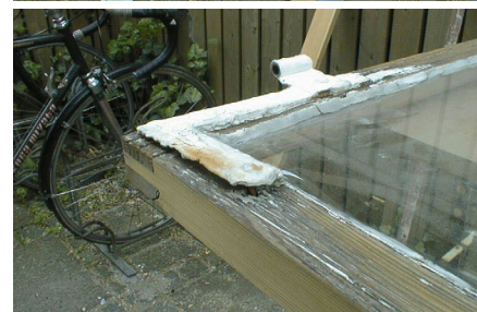
De udvendige beslag er nok gamle vinduers svageste punkt. Hvis der løber vand ind bag disse, rustner beslag, skruer/søm, og træet rådner. Men det er som ovenfor vist muligt at udprope de ødelagte skruehuller i rammerne, og beslagene kan også sagtens sættes i stand og genanvendes. Se informationsbladet Dør- og vinduesbeslag
