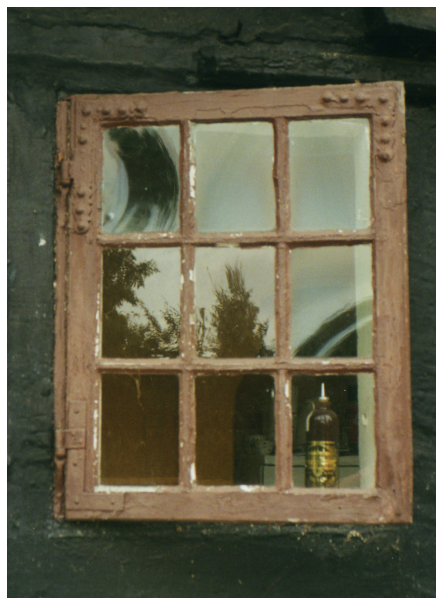
Vindue med det meget sjældne kronglas. Disse bør man helt undgå at tage ud, også selv om der måske er lidt revner i hjørnerne. Den løse kit fjernes forsigtigt, og der kittes oven på den faste, ikke aftagne kit, efter at denne er børstet let med en stålborste eller lignende. Pas også på, når man renser malingen af med en skraber, at den ikke smutter ud på ruden, så denne enten ridses eller går i stykker.
