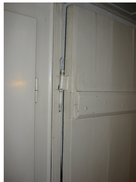
En revledør har på den ene side fået en beklædning, så den ligner en fyldingsdør fra denne side, men fortsat en revledør på bagsiden.
