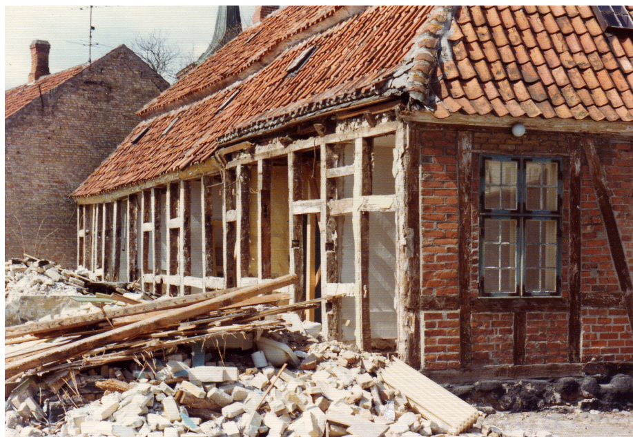
Ved reparation af bindingsværk vil det næsten altid være nødvendigt at tage de murede tavler ud – enten overalt som her, eller delvist ved de områder, der skal repareres.
