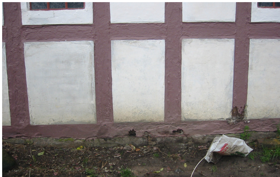
Mange bindingsværkshuse er med tiden blevet overpudsede eller plasticmalede. Begge dele medfører, at bindingsværket ofte rådner under den meget tætte overflade. Dette kan bl.a. ses ved at plastikmalingen bugler og revner mange steder.
