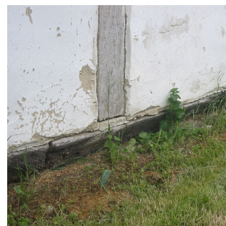
Fodremmen er det mest udsatte på et bindingsværkshus, især som her, hvor den er halvt begravet i terrænet. Så rådner den hurtigt, men det er heldigvis forholdsvis enkelt at skifte den ud.
