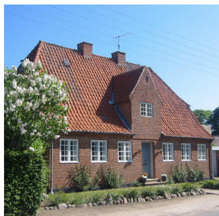
Bakkekammen i Holbæk er et af 'arnestederne' for Bedre Byggeskik, bl.a. fordi to af dens mest markante arkitekter, Ivar Bendtsen og Marius Petersen, boede og virkede her. Røde mursten, opskalket tegltag med halvvalm, hvide sprossevinduer og en fin og enkel gavlkvist.
