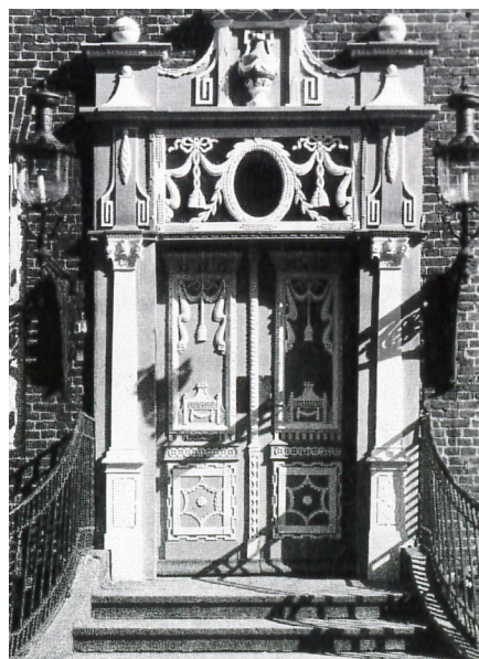
En ualmindelig rigt udformet træportal i Louis-Seize stil pryder det i 1794 opførte Vestergade 14 i Tønder.
