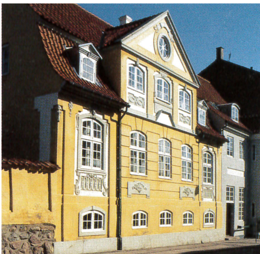
Rigt udsmykket rokokohus fra 1763, Lindegade 4 i Kalundborg, med øreliséner, vinduesindfatninger og refendfugning.
