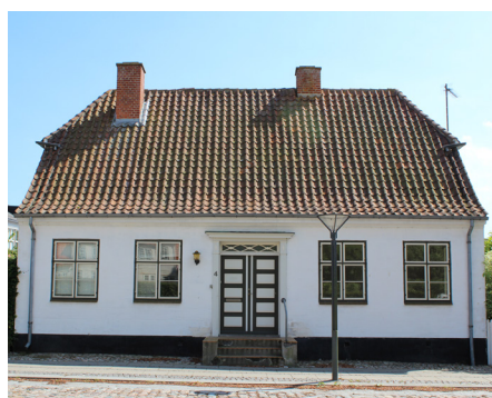
Bedre Byggeskik-hus med nyklassicistiske træk: Pudset facade, den tofløjede, symmetriske indgangsdør med en klassicistisk fordakning båret af indfatninger samt de klassicistiske vinduer i to farver. Foto: Anne Lindegaard.
