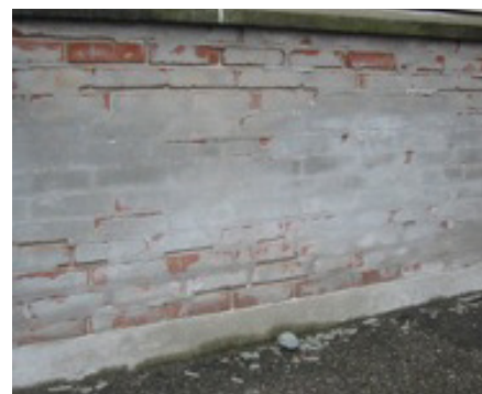
Tyndpuds med KC-mørtel. Ud over at det har en spættet og uensartet overflade, der ikke klæder ældre bygninger, holder Portlandcementen på fugten, den er for tæt og skaller derfor ofte af i grimme skaller.
