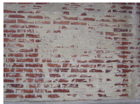
Vandskuret facade. Var meget på mode i 1970'erne, men passer sjældent til bygninger ældre end 1970. Ved tyndpudsning må der ikke anvendes cemetholdig mørtel, da denne både bliver alt for tæt, så murstenene skaller, og derudover bliver umulig at fjerne helt igen, uden at skade murværket.
