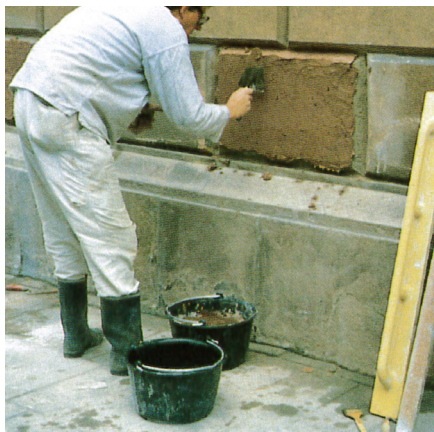
Muring med hydraulisk kalkmørtel, farvet med gyldenbrun farve
