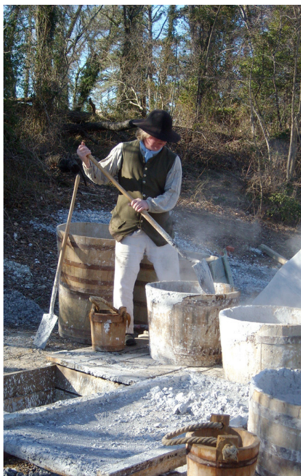
Læskning af brændt kalk – her på gammel vis i et læskekar, hvorefter den læskede kalk bliver siet og hældt ned i en frostfri kule, gravet i jorden. Deraf navnet 'kulekalk'. Foto: Historic Williamsburg, USA
