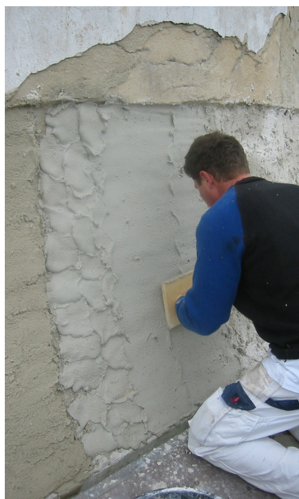
Pudslag på udvendige facader skal kastes på med hånden (øverst t.v.) for at sikre en god vedhæftning. Dernæst glattes overfladen med et pudsebrædt eller en kardesk.
