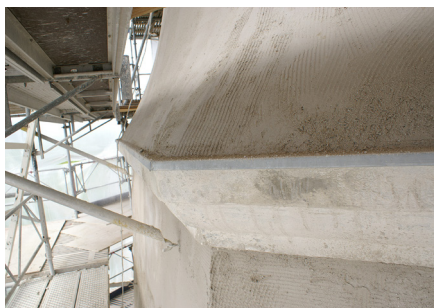
Her ses første lag puds, hvor der er revet op i overfladen, så vedhæftningen til næste lag bliver optimal.
