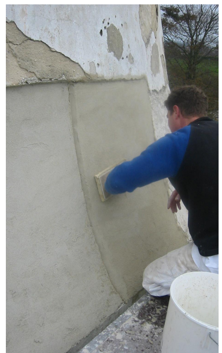
Pudslag på udvendige facader skal kastes på med hånden (øverst t.v.) for at sikre en god vedhæftning. Dernæst glattes overfladen med et pudsebrædt eller en kardesk.
