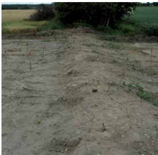
Optrækning af stød og rødder virker ofte ødelæggende på diget og forandrer dets dimensioner.
