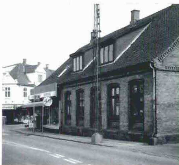
Butiksfacaden tager ikke hensyn til det oprindelige hus.
