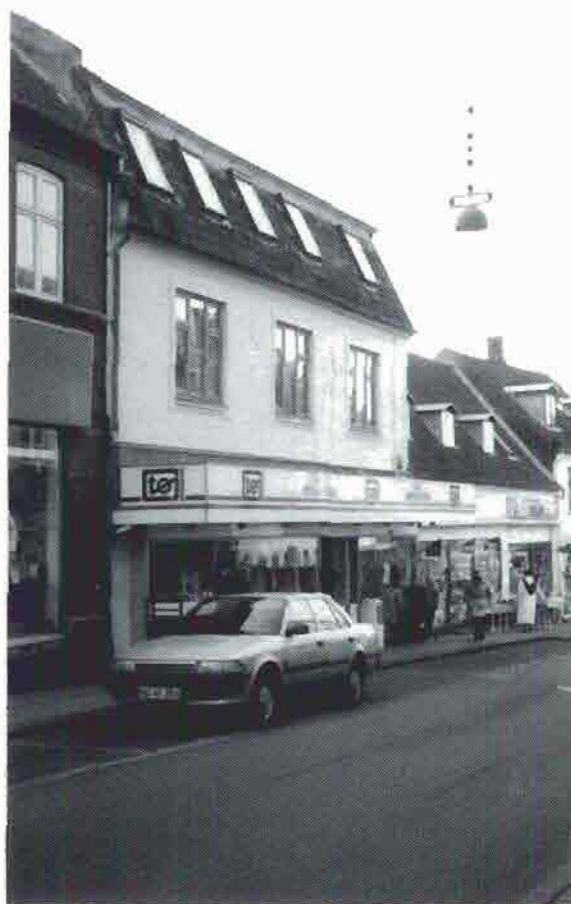
Stor baldakin, der skærer huset over og virker meget dominerende i gadebilledet.
