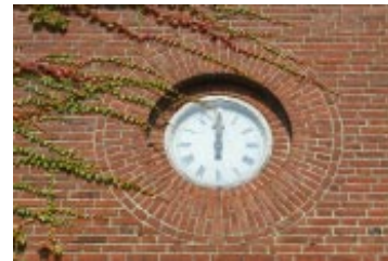
Ur i murværket
