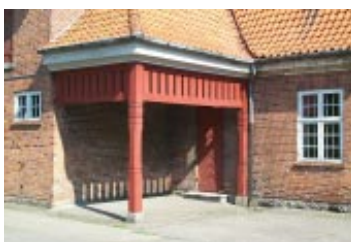
Niche i trækonstruktion
