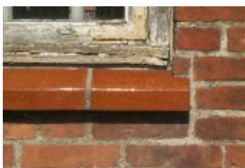
Sålbænk i glaserede røde teglsten Gesims i gule sten
