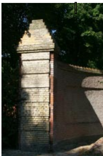
Mur afsluttet med hjørnesøjle
