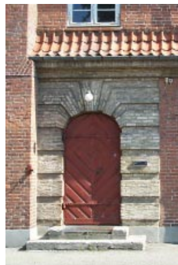
Indgangsparti med trædør
