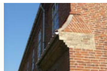
Sålbænk i glaserede røde teglsten Gesims i gule sten
