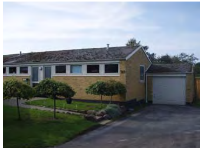
Foto visende oprindelig arkitektur. Skifereternittag, uden udhæng. Inddækninger, tagrender og nedløb i samme farve som husets træværk.
