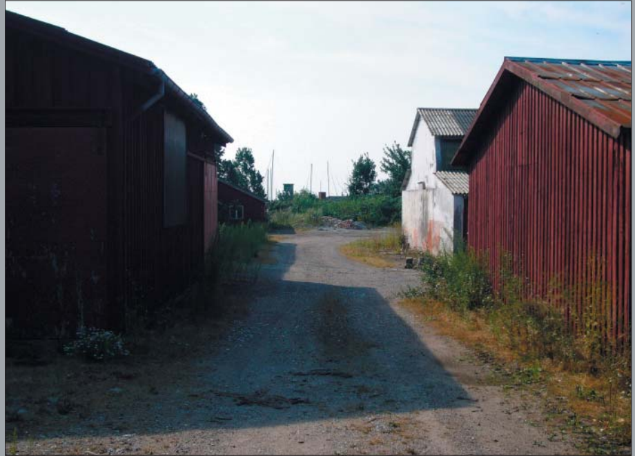
Fig. 8 Foto af savværksbygningerne
