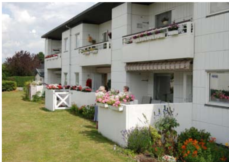
Betonelementer i 60 cm. er grundbyggestenen i Svann Eske Kristensens boligbyggeri på Strandmarksvej i Hvidovre.
