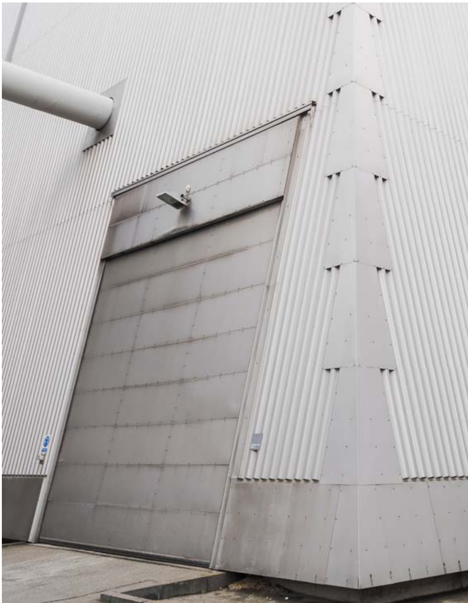
Avedøreværket i Hvidovre Kommune er opført 1990 og udvidet 2001.
