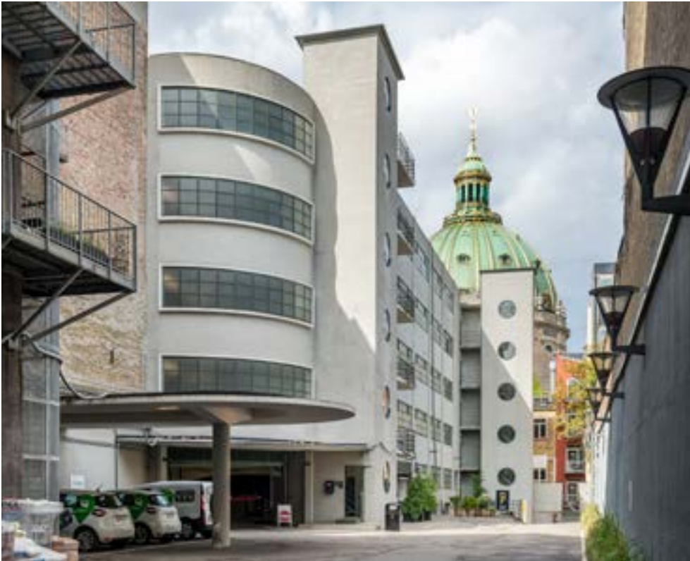
Med til bilismen hører parkering. Her et tidligt parkeringshus i jernbeton i det indre København, Palæ Garager opført 1933.
