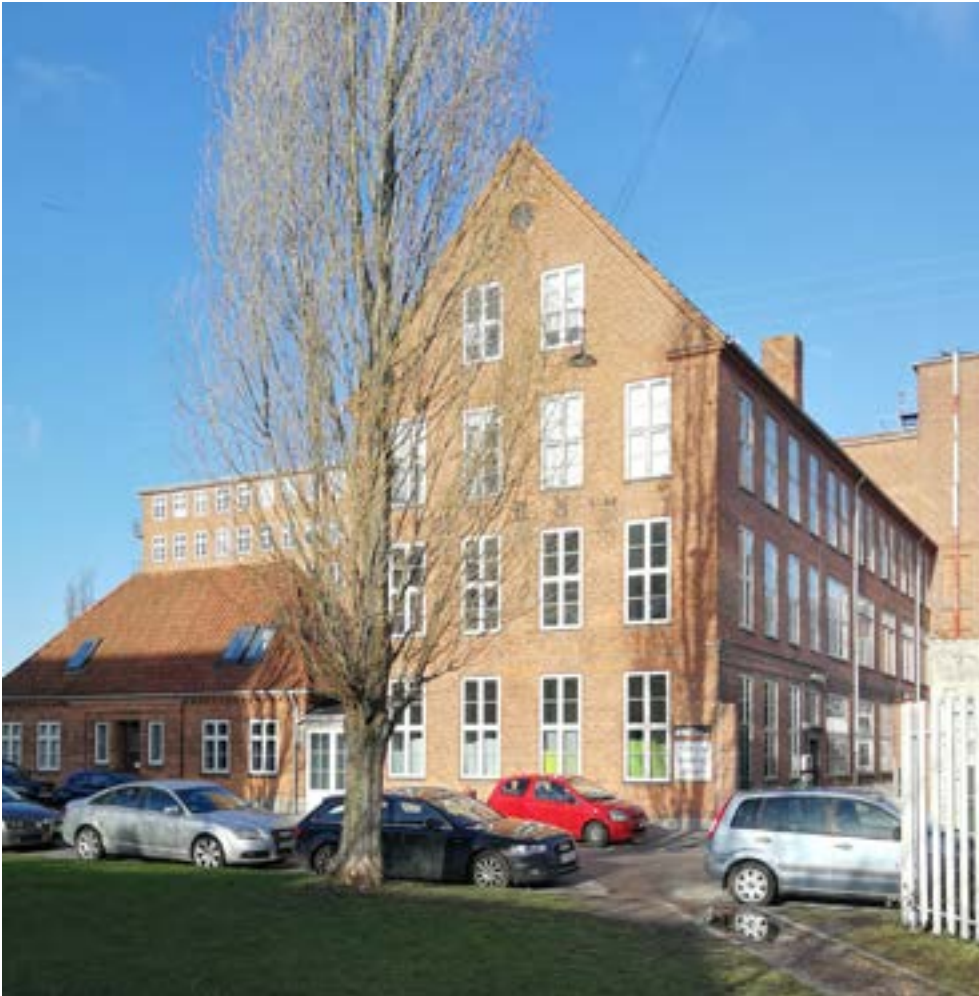
Toms Fabrikker fra 1924 og udvidet 1955 ved Prags Boulevard og tæt på Amagerbanen, Amager. Produktionen foregik i de høje etagebygninger i røde mursten.
