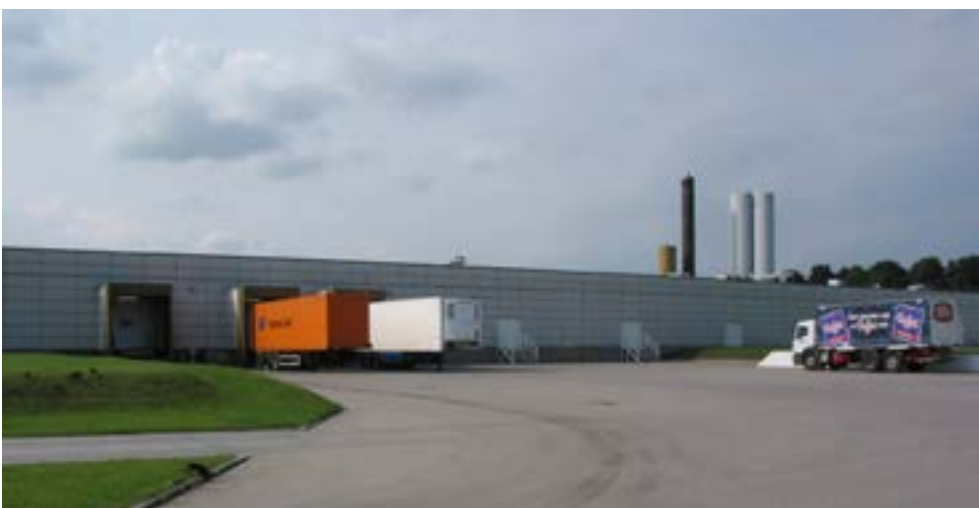
Særlig efter 2. Verdenskrig blev det almindeligt, at produktion og lager blev indrettet i enetages bygninger, de såkaldte fladebygninger. Toms Fabrikker efter udflytningen i 1961 til Ballerup tæt på ringveje og hovedveje.
