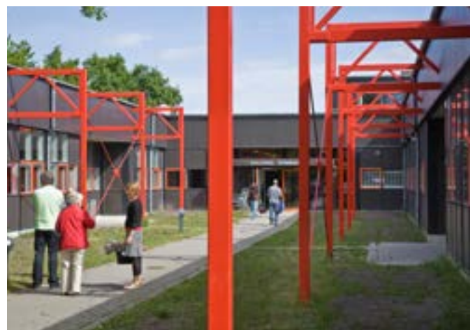
Kolding Gymnasium, 1975 og ombygget 2008.
