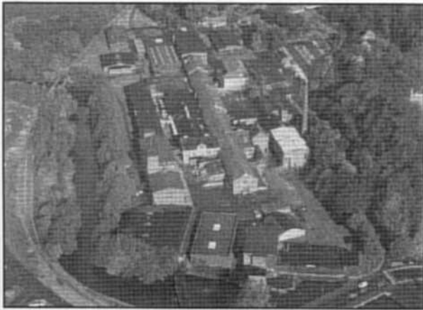
Luftfoto af den tidligere Silkeborg Papirfabrik set fra syd.
