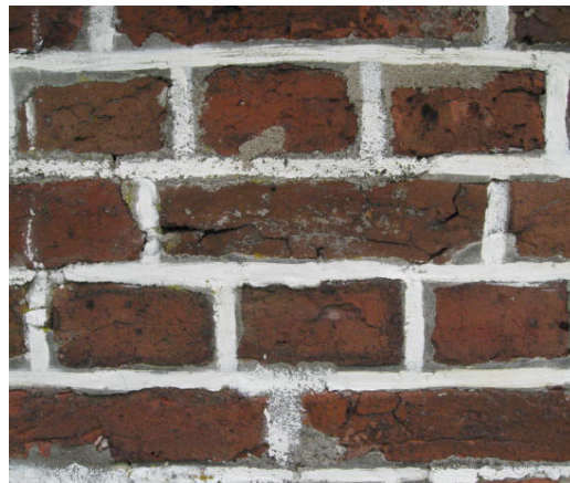
Skrapefuge opstreget med kalk har været meget almindeligt
