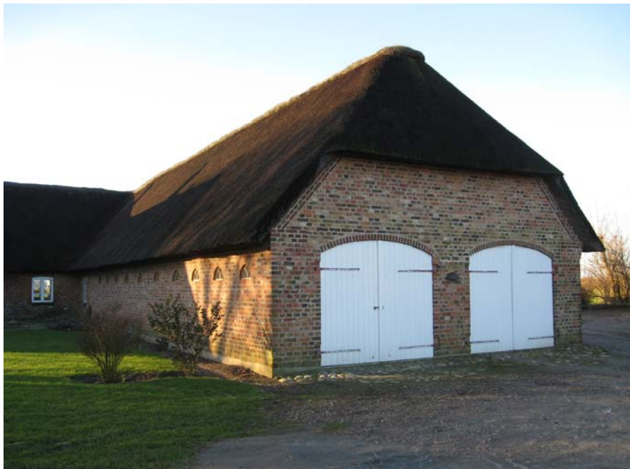
Garager og udhuse kan med fordel indbygges i eksisterende huse, blot der tages hensyn til byggestil og proportioner
