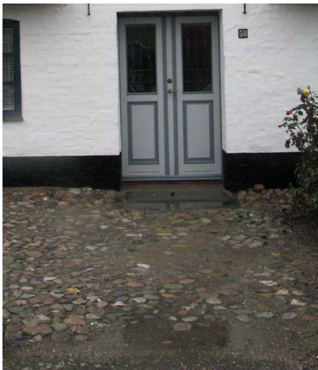
Pigstensbelægning skal bevares og retableres
