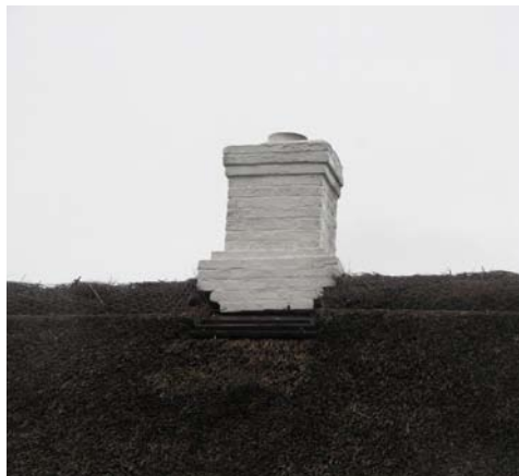
Skorstenens er en del af huset. Derfor skal den bevares og hvor den mangler genskabes. Skorstenes udformning og tilpasning til taget er meget væsentlig.
