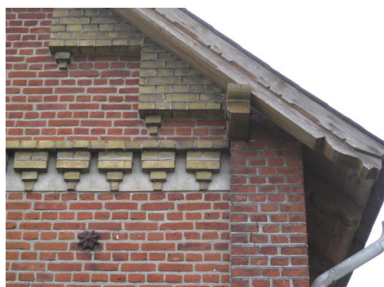
Trempelhusene er udtyret med mange detaljer i murværket
