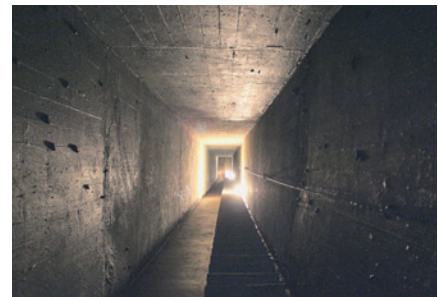
6. Trappeskakt op til den primære nødudgang. Foto: Karsten Pedersen.
