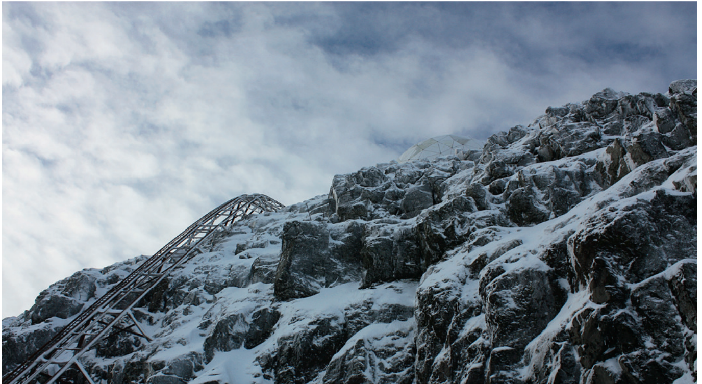
Udsigten fra fjeldvejen ved tunnellen ind til bunkereren. Til venstre ses liften, der gik ca. 50 m ned, næsten lodret, og blev brugt til at transportere tungt og stort gods mellem fjeldvejen og toppen af fjeldet. Midt i billedet skimtes den større radome, hvor radaren var. Foto: Sámal T.F. Johansen 2013.
