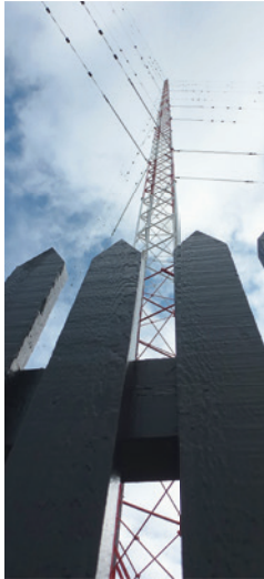
LORAN-masten er ca. 200 m høj og pga. luftfarten er den afmærket med faste røde lys (obstruction lys) på 3 niveauer samt et blinkende rødt lys (Beacon lys) i top og ca. midt på masten. Foto: Morten Stenak 2012.
