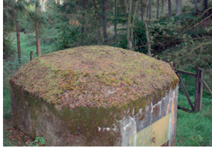
8. Et af de to udstødningstårne til nød-generatorerne. Foto: Karsten Pedersen.
