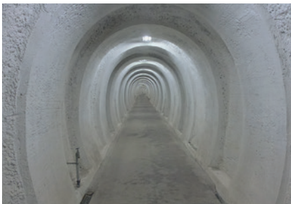
4. Tunnel hen til anlæggets kerne. Foto: Morten Stenak.
