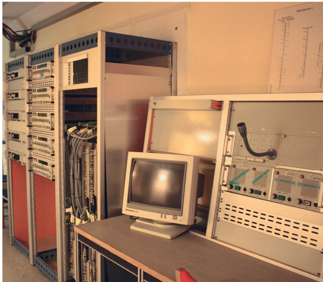
Det nye kommunikations- center og operationsrum i Stevnstort hørte til de mest avancerede i verden, da det blev bygget i 1984. Det var fuldt digitaliseret med muligheder for digital kommunikation og visning og udveksling af radar- billeder. Foto: Thomas Tram Pedersen 2011.
