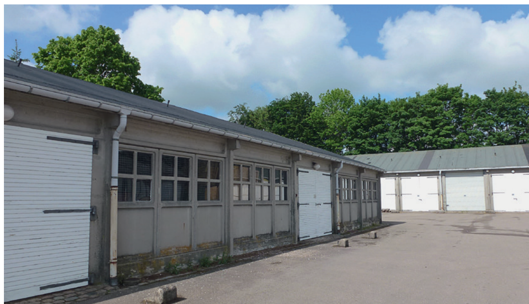
I tilknytning til mange af landets kaserner opførtes i 1950'erne og 60'erne en række mobiliseringsdepoter med udrustning til genindkaldte soldater. Mobiliseringsdepot Regstrup er ét af en række ens depoter fra perioden. Foto: Morten Stenak 2013.
