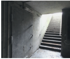
En af flere indgange til det sikrede reservebehandlingsafsnit under Kommunehospitalet i København. Foto: Poul Holt Pedersen 2013.
