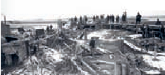
Byggeriet af Bagsværdfortet d. 20. december 1892.
