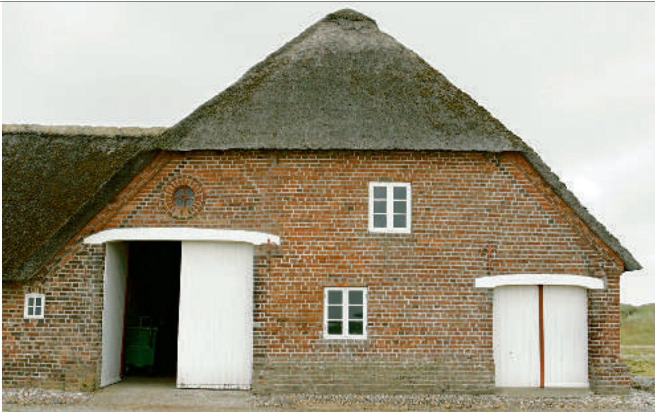
Gavlparti af Bankgårdens ladebygning's østgavl med karakteristiske detaljer, Husby Klitvej 23.
