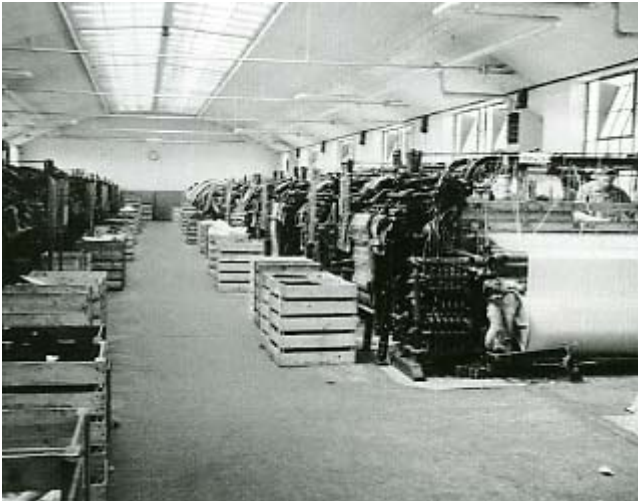
Væveribygningens øverste etage med de mange CFS væve, som erhvervedes til klædefabrikken i Herning, da Modewegs fabrikker i Brede lukkede i 1956. Foto: Løvstad 1959.
