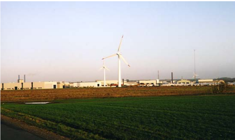
Vestas i Lem. Foto: STP.
