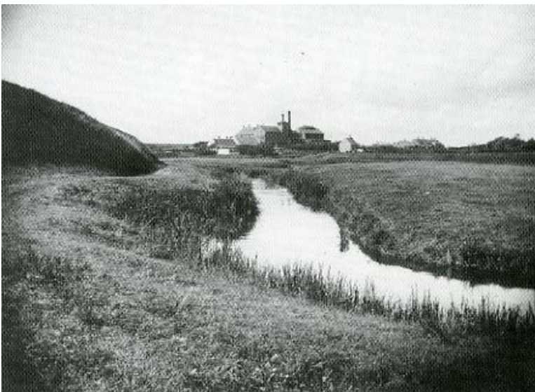
Da Rs. Færch flyttede Herningvej erhvervede man Holstebros gamle Aktiebryggeri som ses på dette billede. En del af det gamle bryggeri indgår stadig i Orlic Tobaccos bygninger på Herningvej 2. Efter Graugaard.
