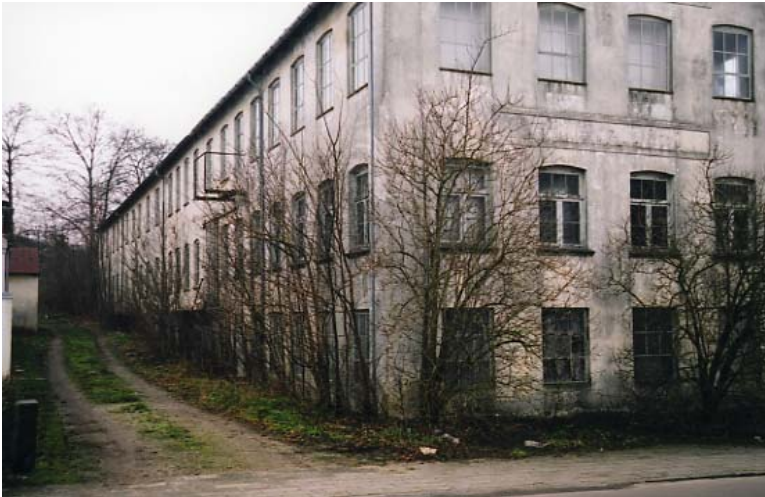
Leopards gamle fabriksbygning opført af flere gange. Foto: STP.
