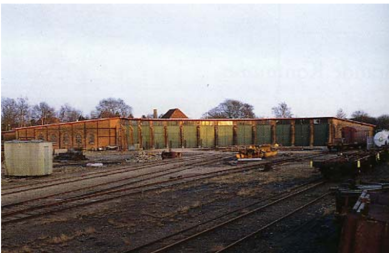
Remisen i Brande som den så ud før sporanlægget blev fjernet. Foto9: STP.
