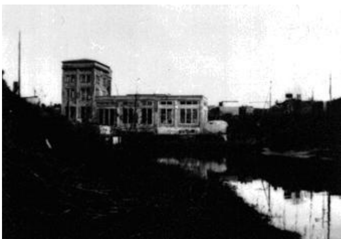
Karlsgårdeværket set fra vest efter udvidelsen i 1940'erne. Fra Fiskeri- og Søfartsmuseets arkiv.
