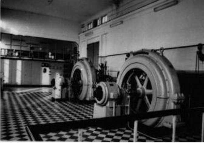
Fra maskinhallen. I forgrunden de to Titangeneratorer fra 1920, i baggrunden manøvrerummet. Fra Fiskeri- og Søfartsmuseets arkiv.
