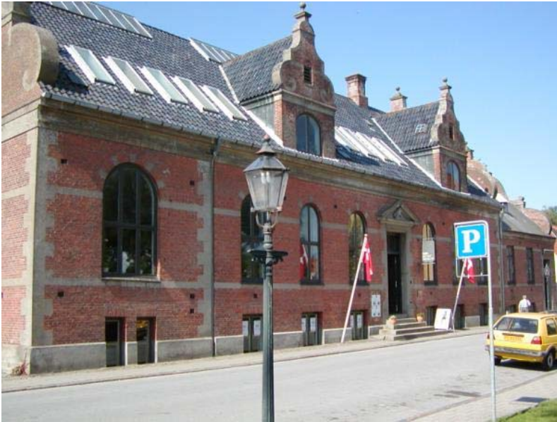
Balthazar Giørtz' villa Sct. Nicolaj Gade 10A-B. Foto: Den Antikvariske Samling, Ribe, 2004.
