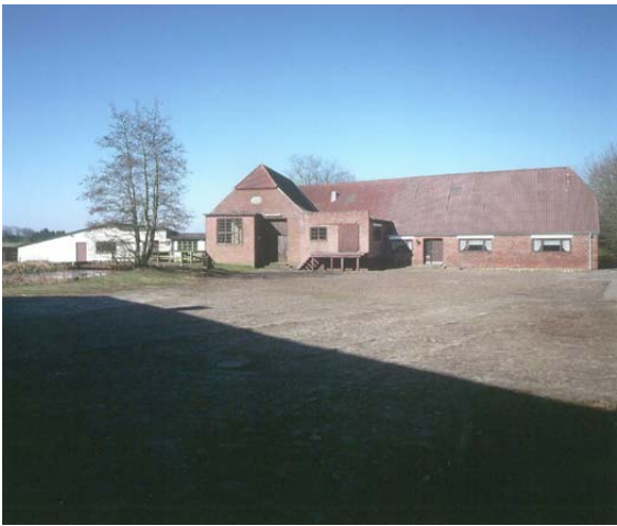
Møllen set fra gårdspladsen med fra højre stuehuset, møllehuset og turbinehuset. Fra Fiskeri- og Søfartsmuseets arkiv.
