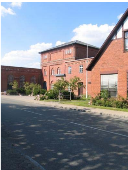
Alfa fotograferet fra sydøst. Fra venstre mod højre ses maskinhallen (1915), smelteribygningen (1898), folkebygningen (1920) og kontorbygningen (1913). Foto: Linda Klitmøller, 2004.
