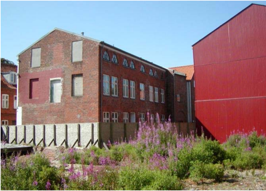
Chr. Giørtz bomuldsvæveri syd for Domkirken. Bygningen med de spidsbuede vinduer i den øvre ½etage er Sønderportsgade 4. I forgrunden brandtomten efter Sønderportsgade2/Torvet 13. Foto: Den Antikvariske Samling, Ribe, 2004.
