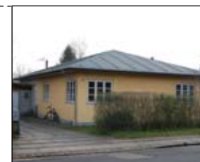
Selvbyggerhus med afsæt i 1920-erne. Under næsten konstant om- og udbygning siden 1960 og senest grundlæggende ombygget efter år 2000 med materialemæssig respekt for bygningshistorien.
