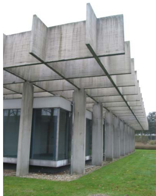
Bygningsmaterialerne er græs, sten, stål, glas og beton
