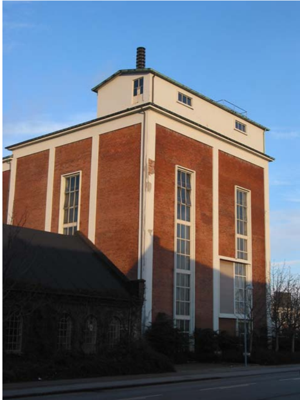
Skalasammenstød mellem bygningskroppe
