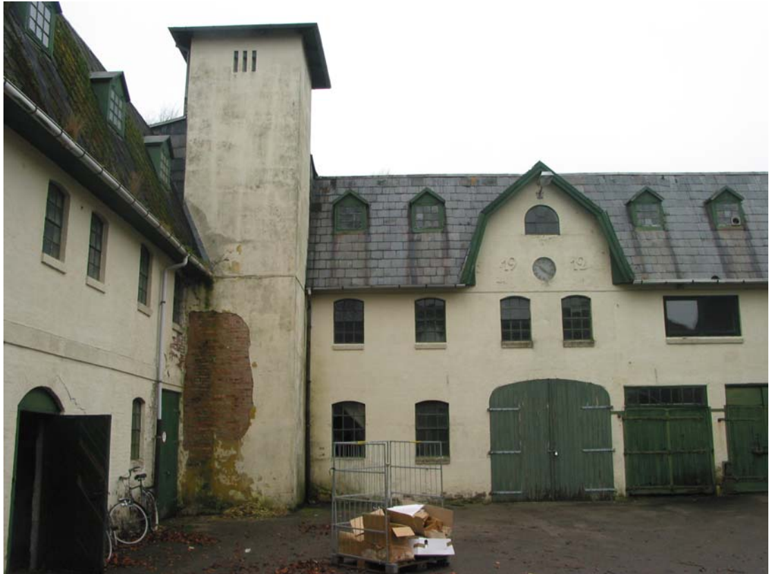
Fabrikkens gårdrum med mindelser om en amerikansk lade og forbindelsesrum og ramper mellem bygningsdele
