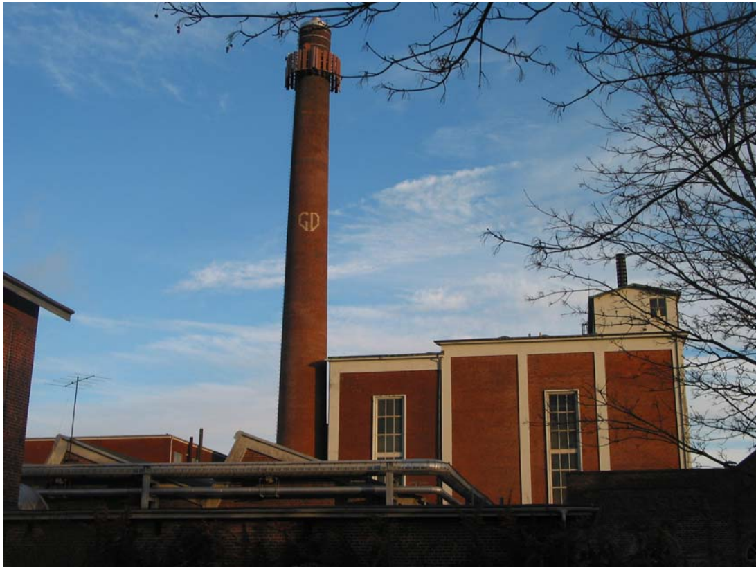
Den store centrale industrihal med skorsten i baggrunden og produktionshaller med skrå ovenlys i forgrunden
