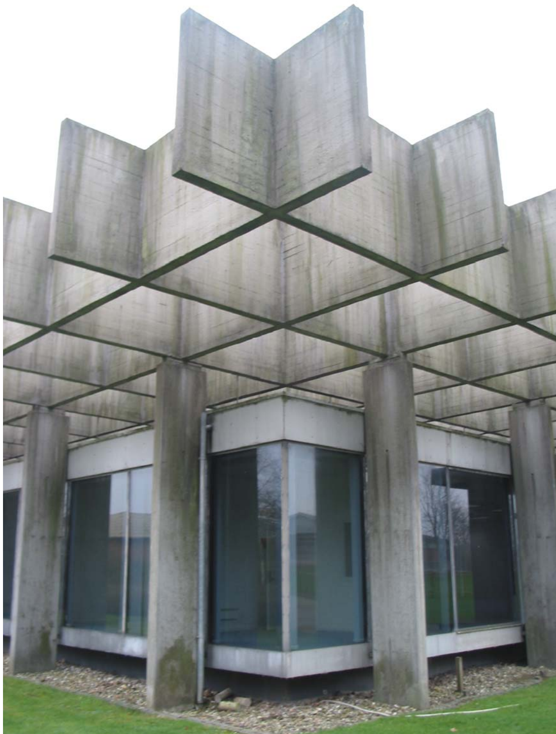
Billedet viser bygningshjørnet med den svævende stålindrammede glaskasse i en ophængt konstruktion
