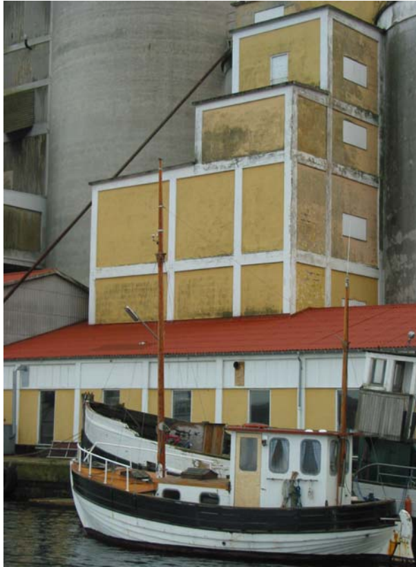
Silo og industribygninger i beton ved vandet
