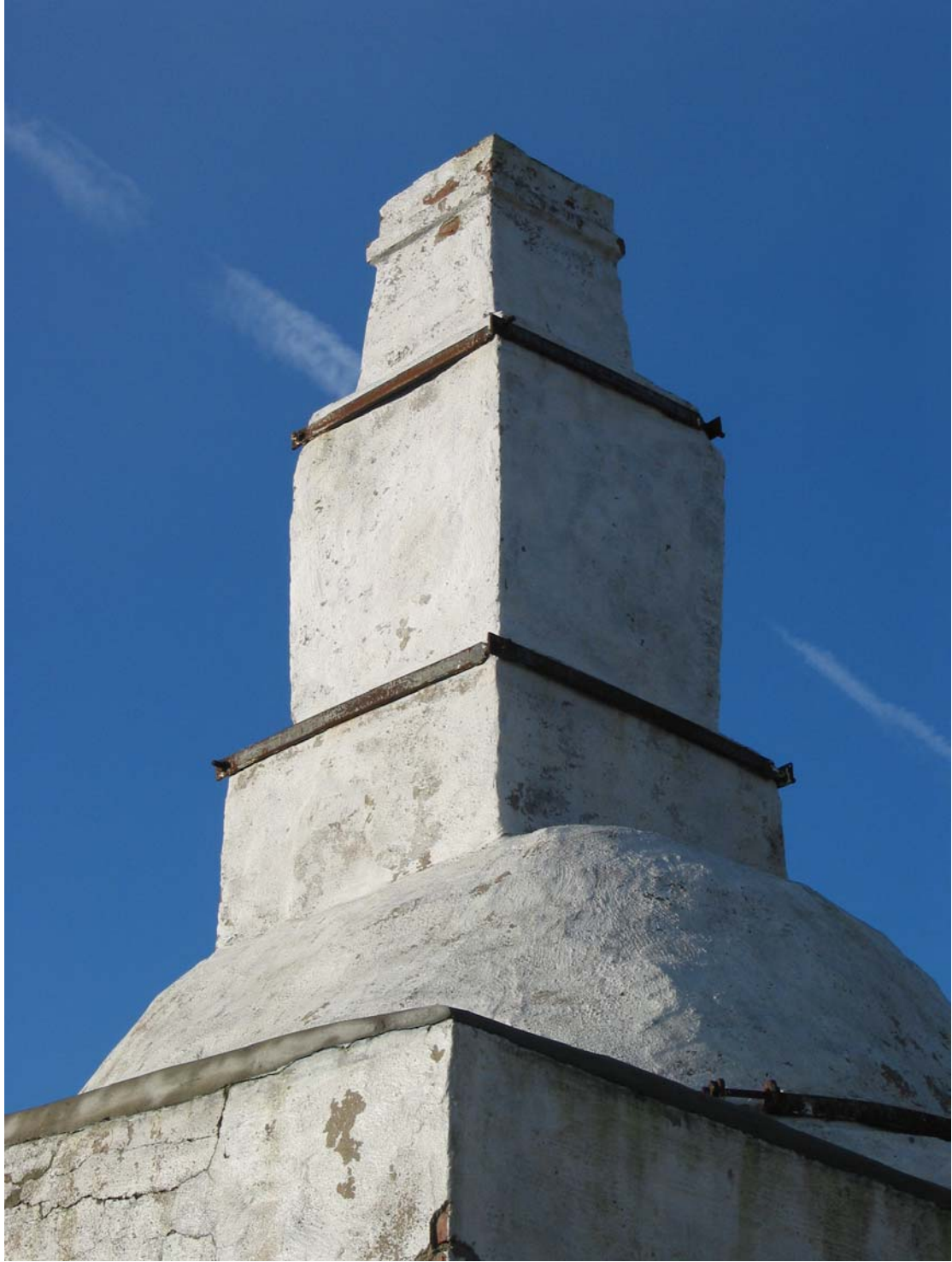
En nyrenoveret skorsten på de fredede kalkkøvnene ved Rugårdsvej 28
