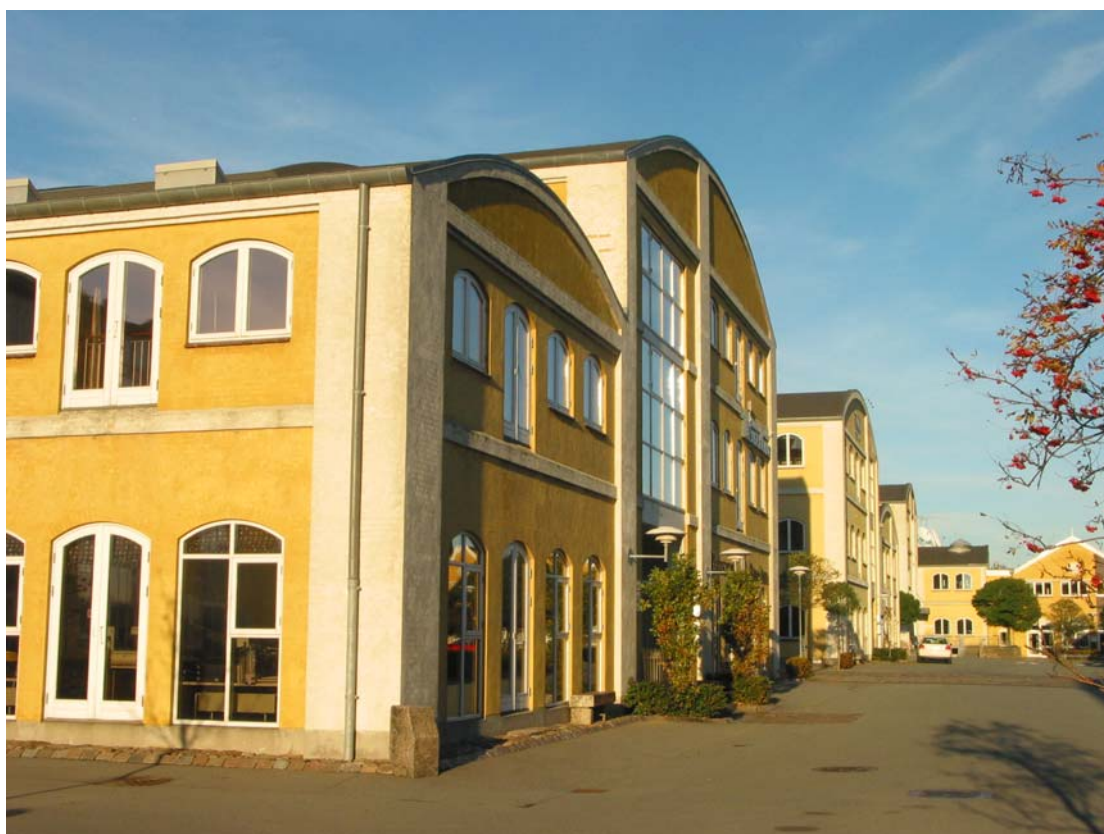
Betonhallerne med buede tøndehvælv er istandsat med upassende vinduesprofiler og indrettet med snævre karakterløse rum, der ikke refererer tilbage til bygningens historie
