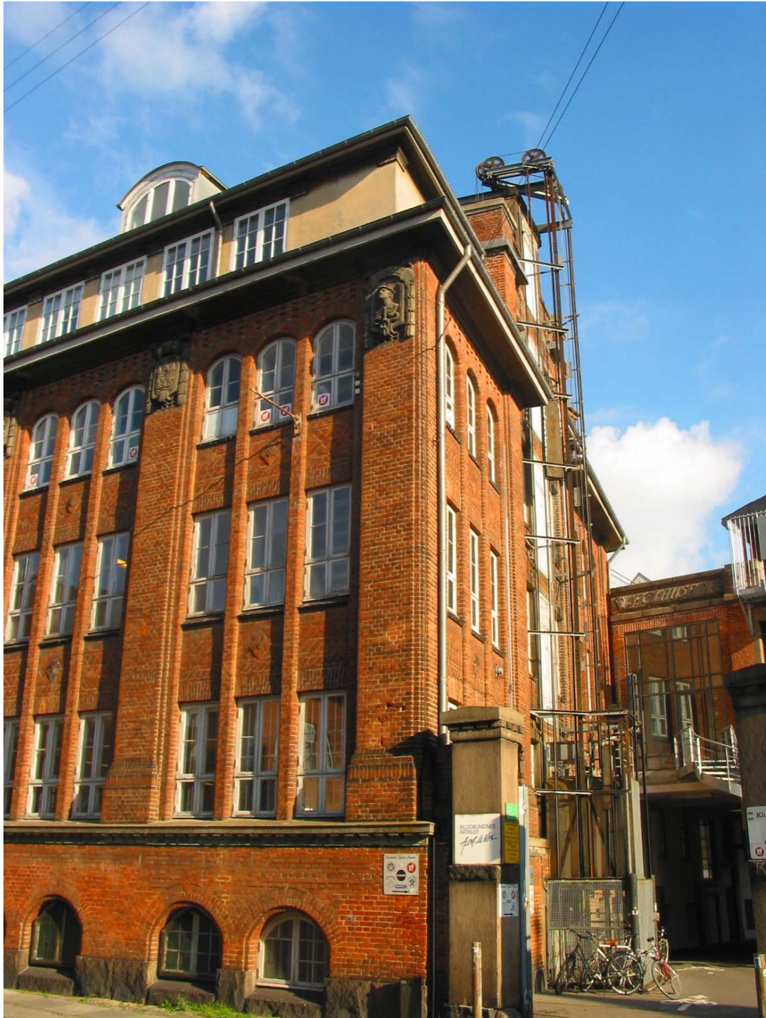
Den profilerede fabriksfacade med sjove ornamenter.
